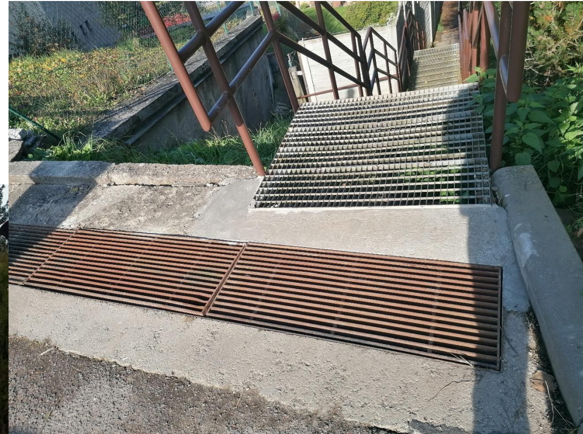
schody na Větru
