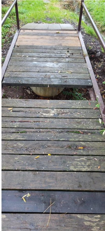
lávka Dolní Třešňovec
