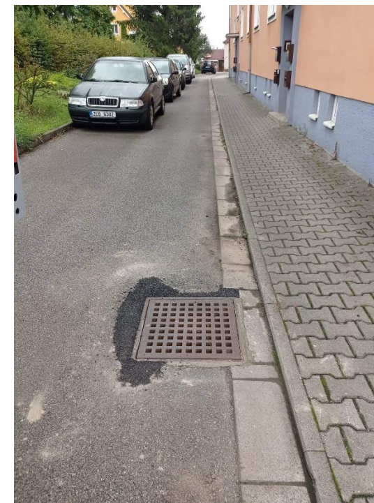
oprava kanálu Žižková
