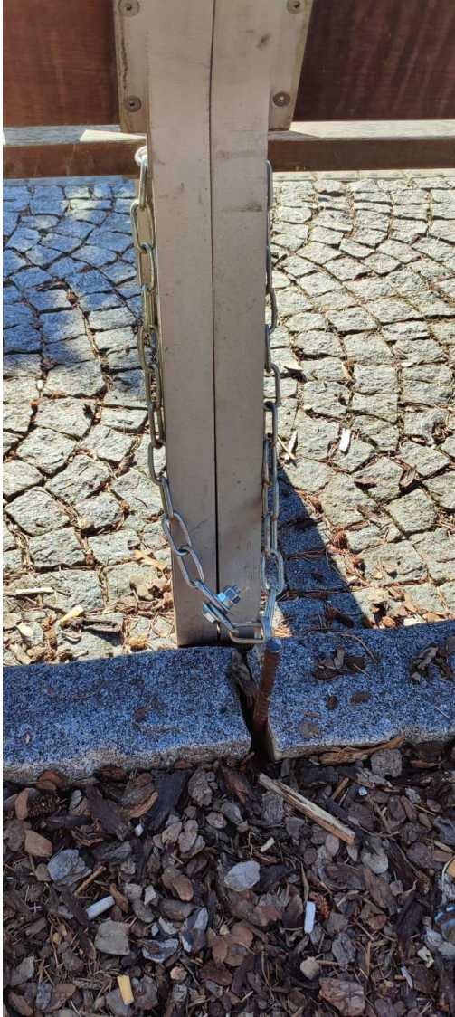
ukotvení laviček Dělnický dům
