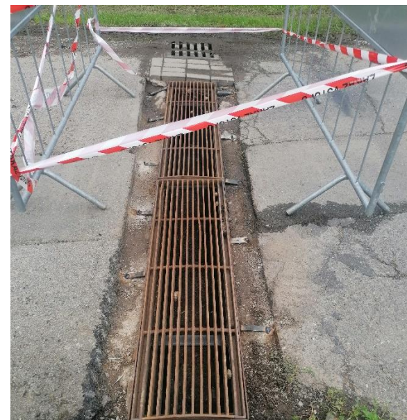
kanál D.Třešňovec - opr. a svaření železného roštu
