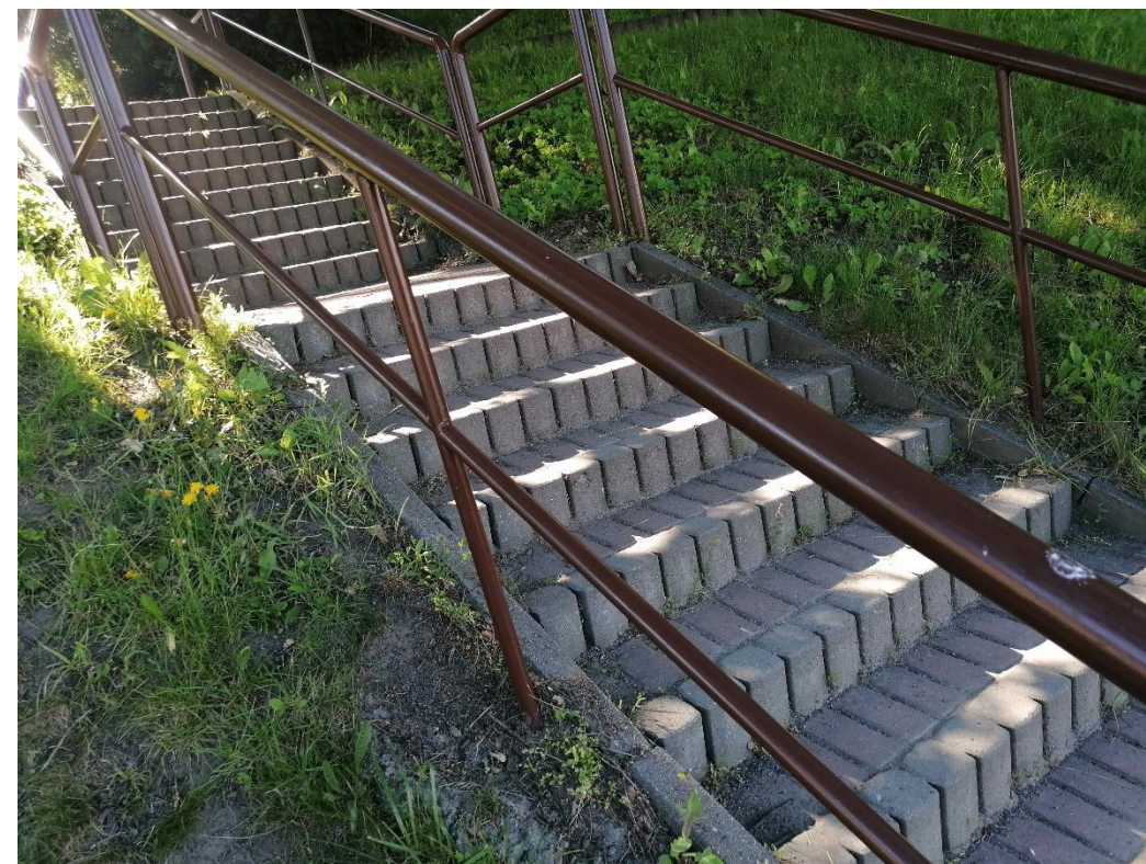
nátěr zábradlí ul. Údolní směr Valy
