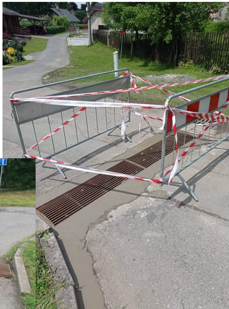
kanál D.Třešňovec - opr. a svaření železného roštu
